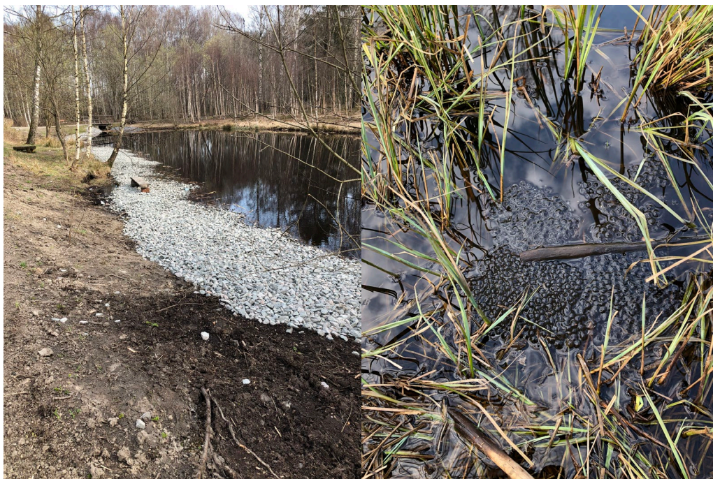
Figur 8. Damm 2 och västra strandkanten (t.v.) som rensats på vegetation och krossgrus lagts ut. Nordöstra strandkanten (t.h.) som inte rensats hyser vissa grundare områden där grodor lekt och lagt rom.
